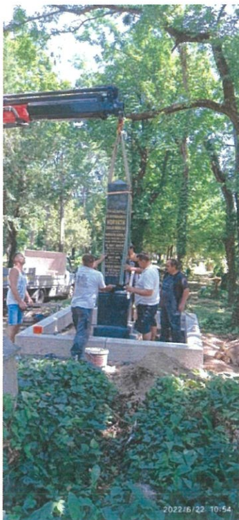
A záróelem, a piramis bemelése és illesztése. NPA tábla 15x7 cm, a kőkeret fejrésznél.
