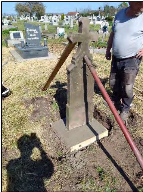
7. (előtte-utána) földben volt, betonba öntés, drótképezés, sósavazás
