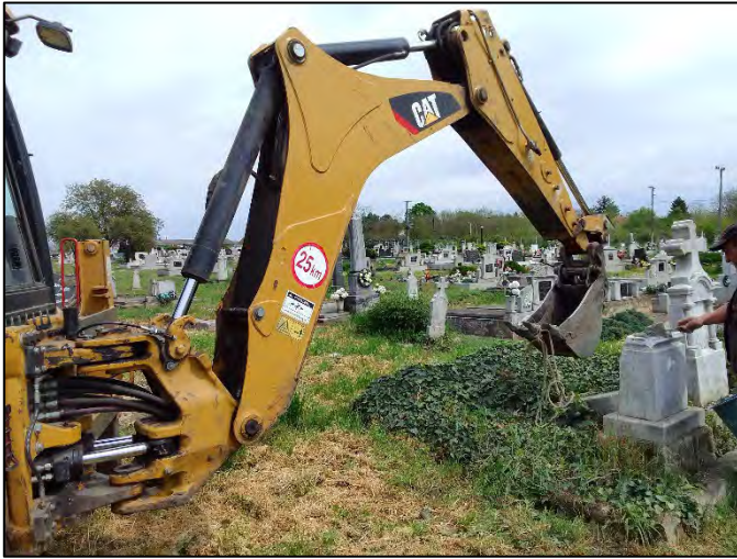
8. (előtte-utána) markolós emelés, ragasztás, drótkéfézés, sósavazás
